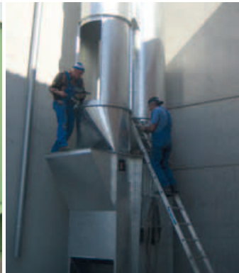
Elevatorfuß mit Spannlukenrohr
