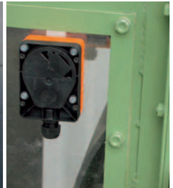
Schiefelaufüberwachung unten
